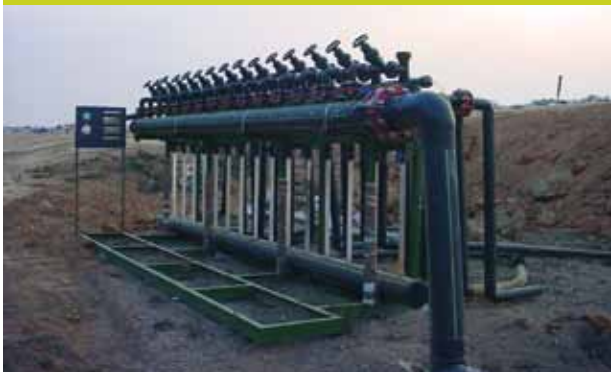
Estación de regulación de biogás en el vertedero de Can Mata
