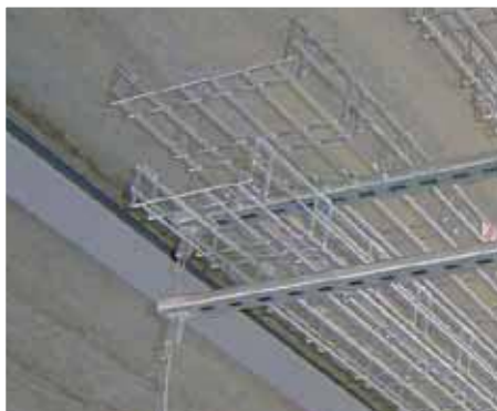
Bandeja portacables en varias alturas
