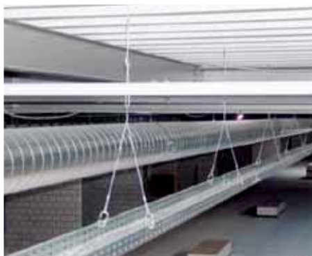
Bandeja portacables tipo ranurada
