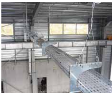
Bandeja portacables tipo ranurada
