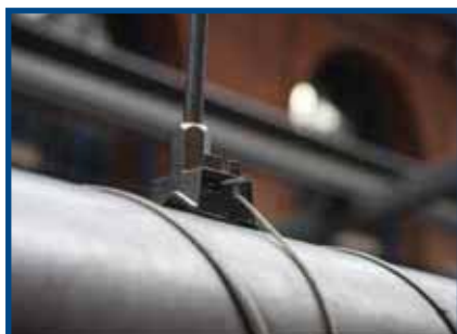
Conducto en espiral de 250 mm
