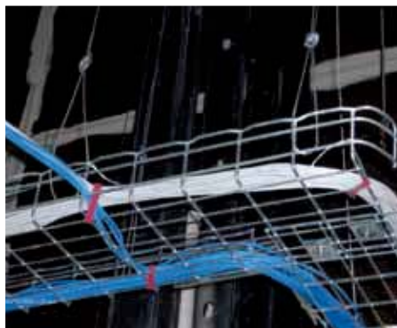
Bandeja portacables tipo rejilla
