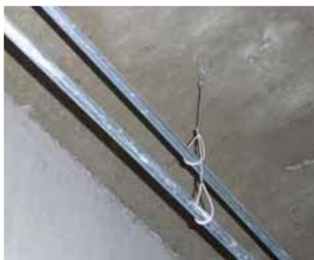
Doble tubería vertical
