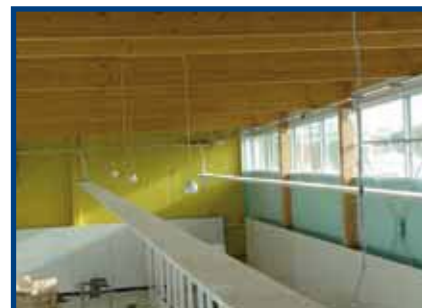
Línea de iluminación
