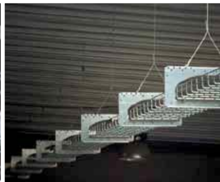
Bandeja portacables tipo rejilla
