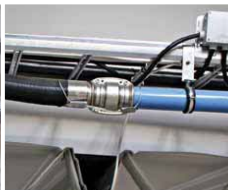
Aseguramiento de conductos de aire
