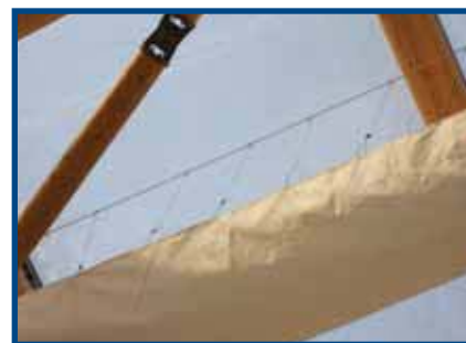
Conducto textil
