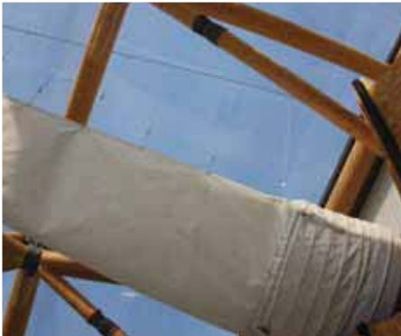
Conducto textil
