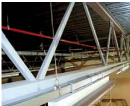
Canalizaciones eléctricas prefabricadas
