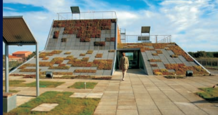
Residencia de Ancianos de Camarzana de Tera (Zamora) Arquitecto: Javier de Antón Freile
