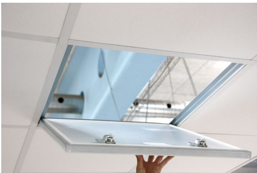
Fácil acceso a las instalaciones.
