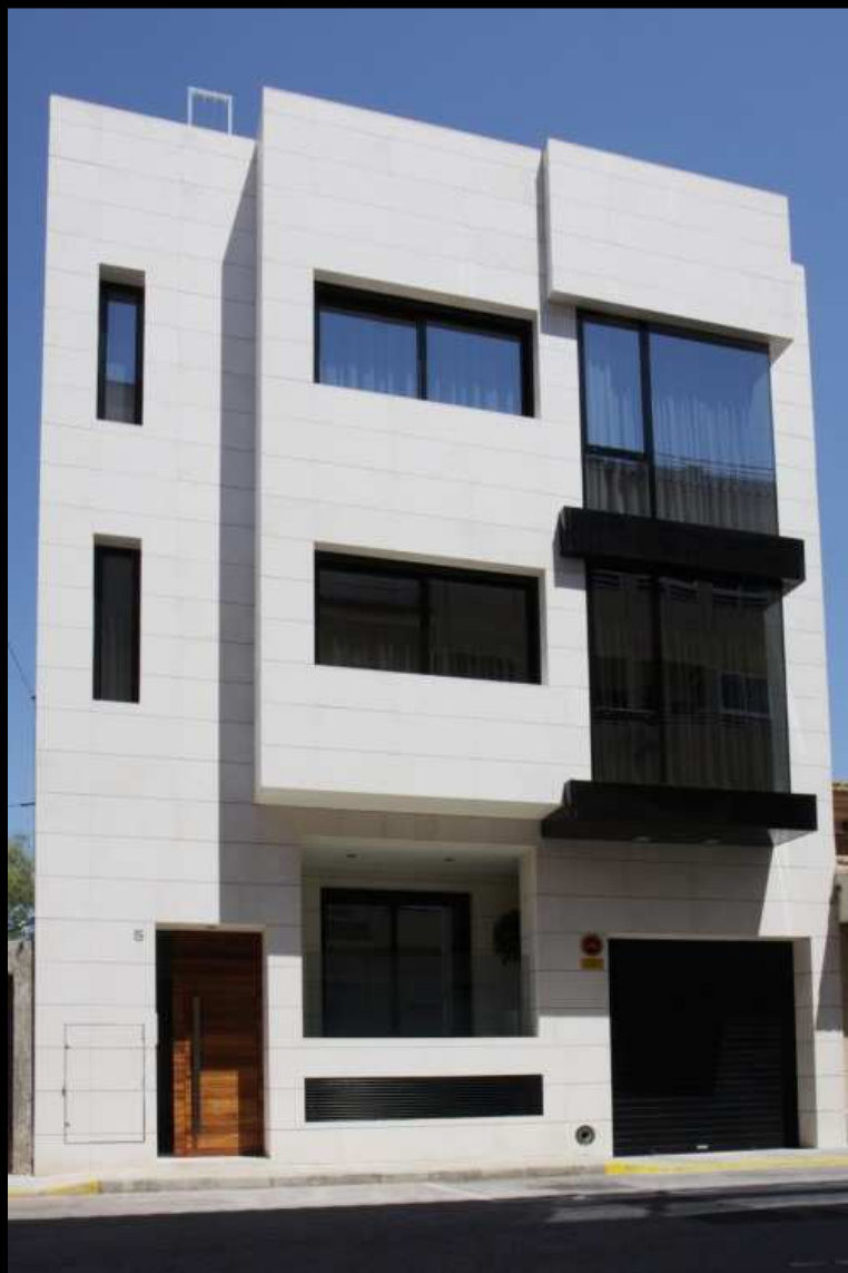
edificio de 3 viviendas en Los Montesinos
