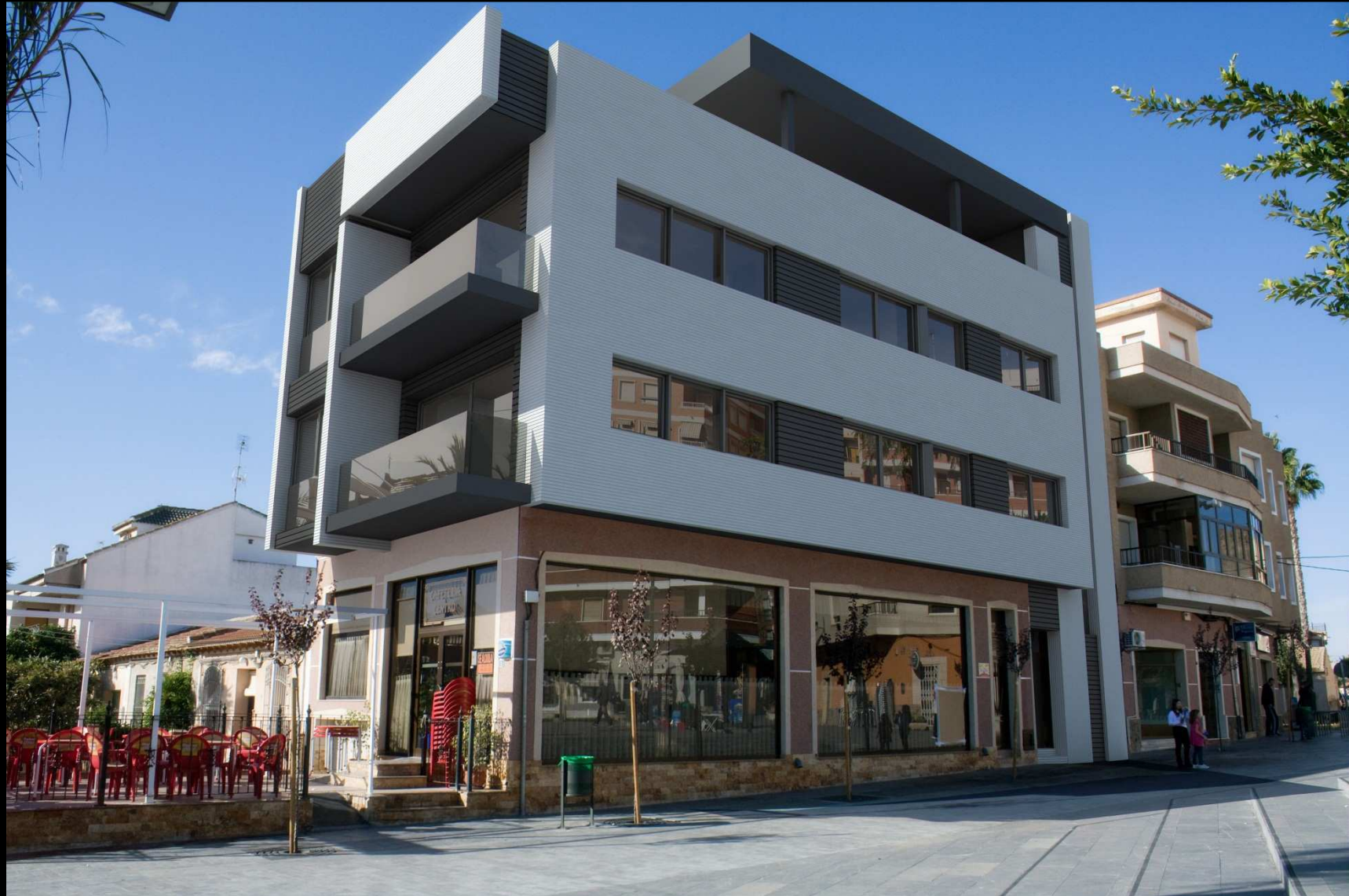
edificio de 2 viviendas en Los Montesinos
