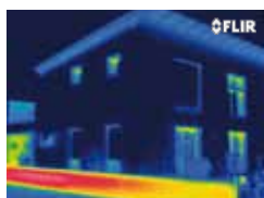
La imagen térmica muestra la calidad del aislamiento de una casa de bajo consumo energético.
