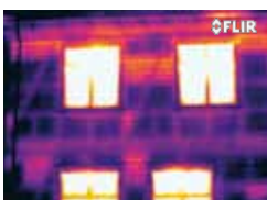
Construcción con estructuras prefabricadas. Muchos de estos módulos carecen de aislamiento, como se observa por sus colores más cálidos.
