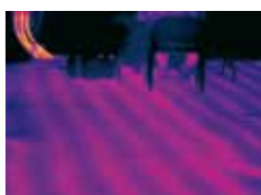
Fugas en una red subterránea centralizada de calefacción urbana.
