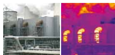
Deterioro de aislantes.
