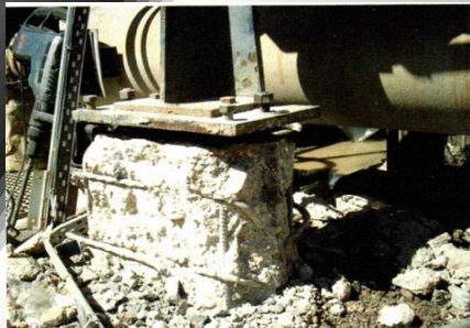
Reparación de anclajes y bancadas para motores, prensas, etc...
