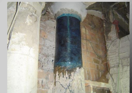
Reparación superficies mediante vulcanización, revestimientos químicos, fibras de carbono
