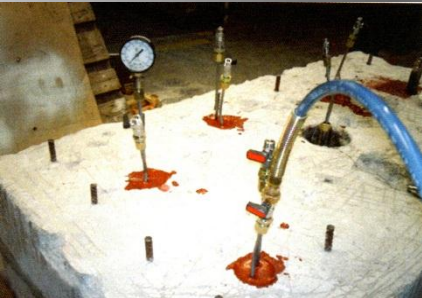
Reparación de anclajes y bancadas para motores, prensas, etc...
