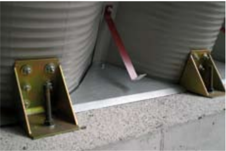
Detalle anclajes 2 Anchorage detail 2 Détail ancrages 2
