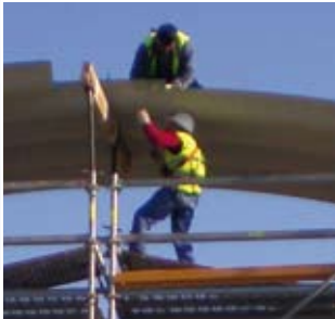
Montaje techo 1 Roof erection 1 Montage du toit 1
