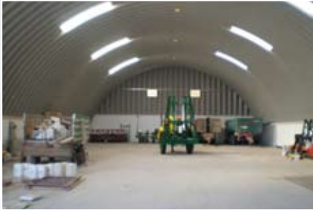
Fotografía desde el interior de la nave Photograph from the inside of the warehouse Photographie à l’intérieur du magasin
