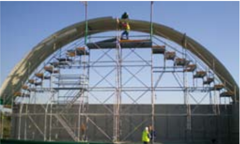
Montaje techo 2 Roof erection 2 Montage du toit 2
