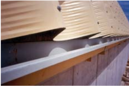
Detalle canalón Guter detail Détail gouttière
