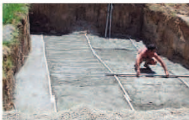
Hormigonado de la base
