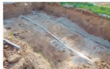
Colocación de plantillas
