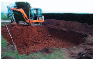
Excavación del terreno
