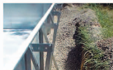
Relleno de gravas
