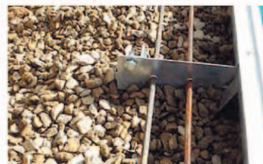
Colocación de ferralla superior
