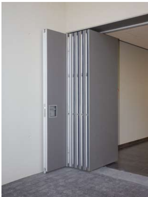
Almacenamiento tabique móvil monodireccional con panel batiente.
