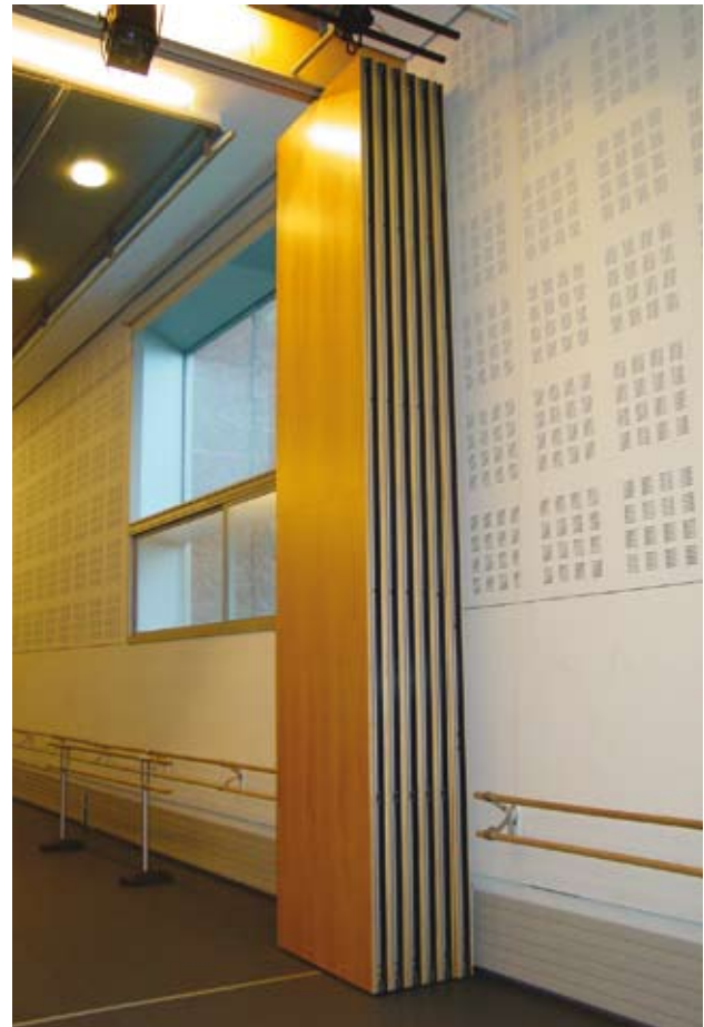
Detalle operación de cierre tabique monodireccional.
