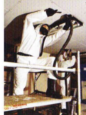
Desamiantado falso techo.
