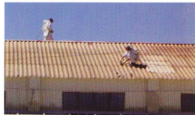
Cubierta de fibrocemento.
