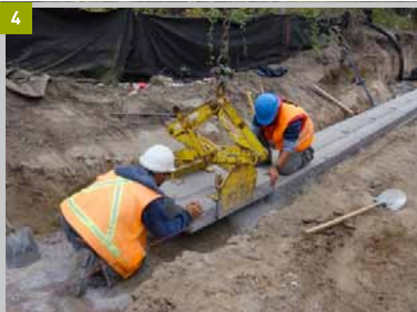
Colocación del bloque y alineación.
