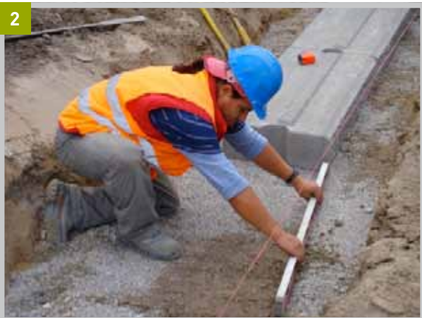
Nivelado de la base.
