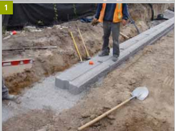
Formación y compactación de la base. La profundidad de la zanja debe permitir enterrar la primera hilada de SienaStone.
