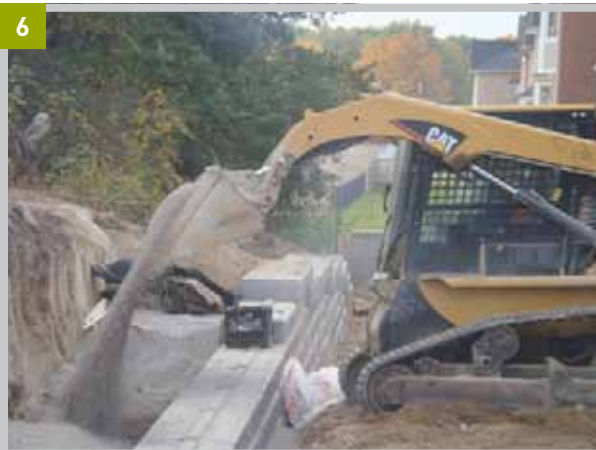
Colocación de las hiladas superiores y relleno con material drenante.
