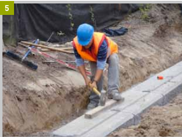
Nivelación. La nivelación de la primera hilada es fundamental, ya que será la que guiará la colocación de las piezas superiores.
