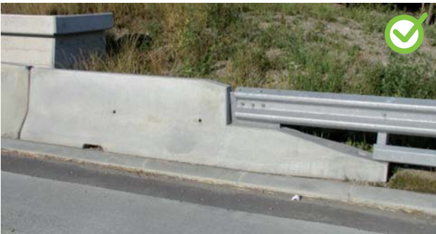
Transición instalada CORRECTAMENTE.
