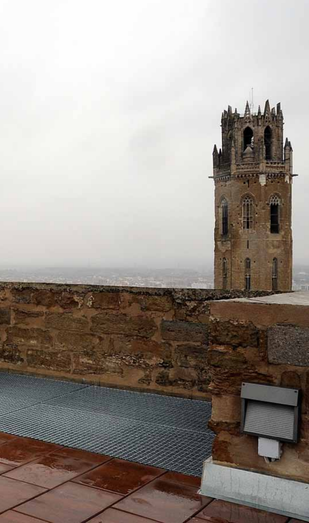
Pavimentación del palacio de La Suda, Lleida. Losa GLS Teneré 60x40x8.
